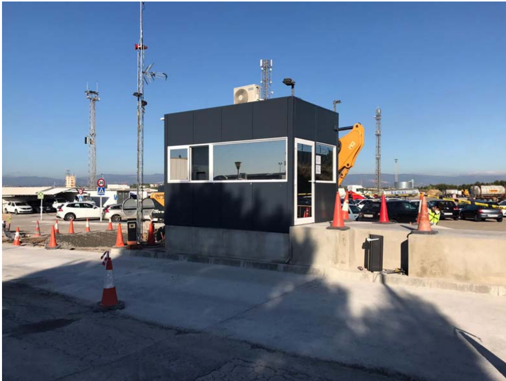
Obra a l'aparcament de mercaderies perilloses de Riuclar
